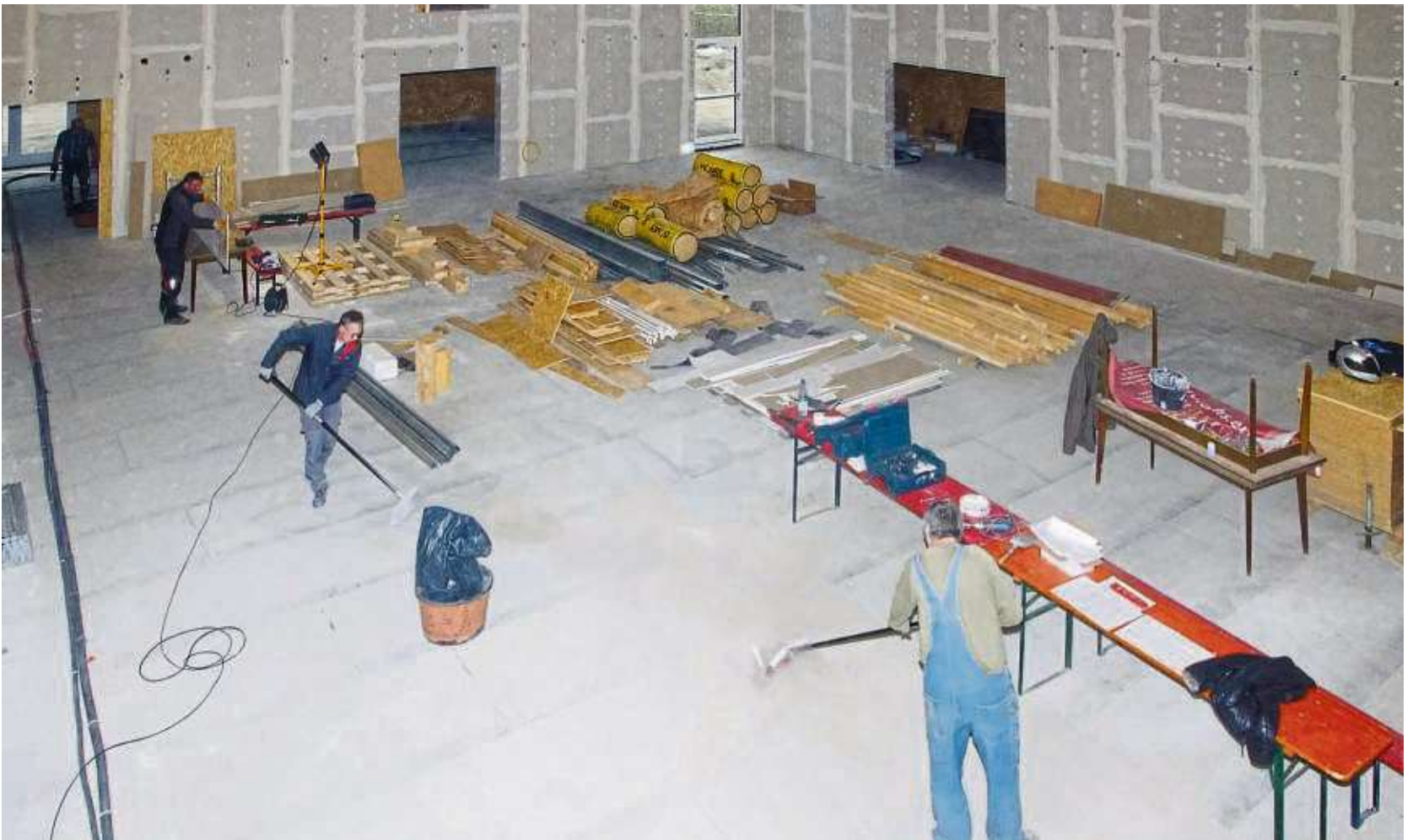
Bei den Sportfreunden geht die Arbeit im Neubau voran. Eine Gruppe ehrenamtlicher Handwerker bringt viele Eigenleistungen ein.
